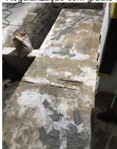
Figura 8 - Regularização com graute tixotrópico
