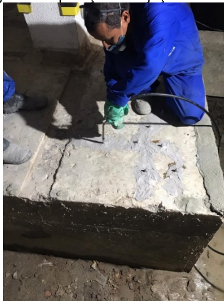
Figura 7 - Aplicação de injeção nos bicos
