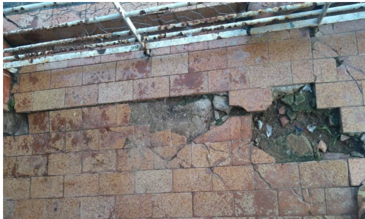
Figura 5 - Abaulamento do piso
